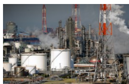
化学薬品や石油・ガスを扱う工場等
